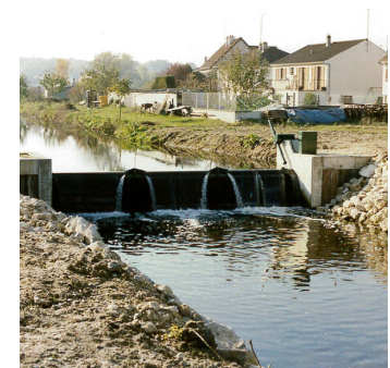
Barrage de Montalibert - Châlette-sur-Loing
