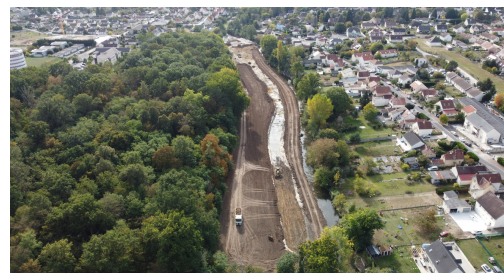
ZEC en travaux - Octobre 2023
