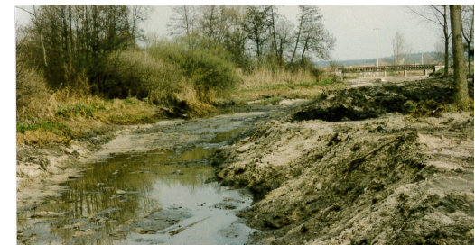
Pendant travaux de rectification
