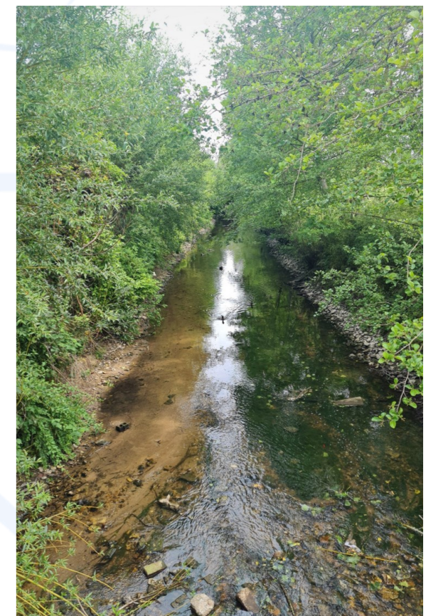
Le Solin avant travaux sur Pannes
